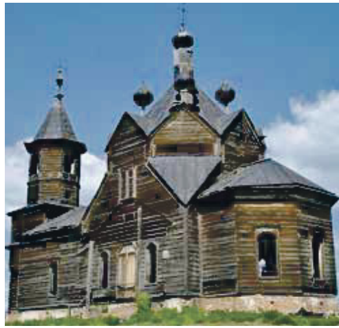
Церковь в Барабаново до реконструкции
